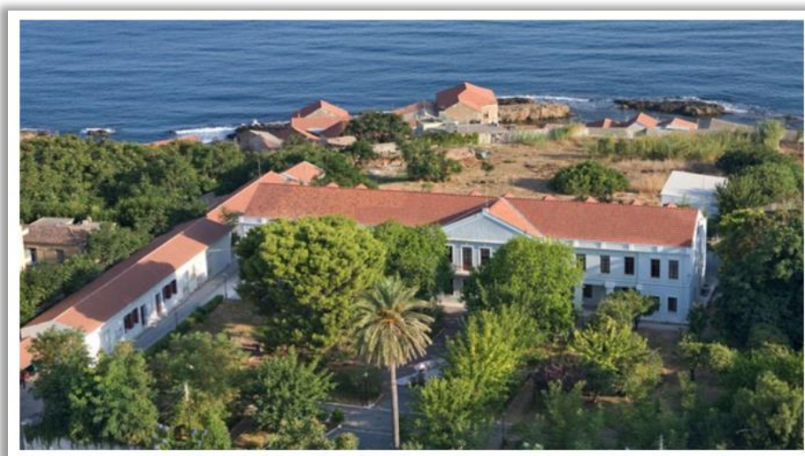
Εικ. 7. Άποψη της Γαλλικής Σχολής στη Χαλέπα
